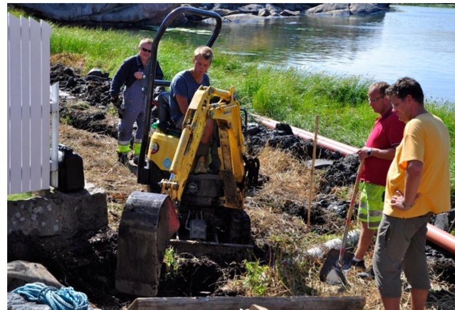
Arbetet med den nya avloppsanläggningen går framåt. Här ser vi Albin Kylbrink vid spakarna vid grävning på Strana. Handgrävningen svarade bl.a Bengt Håskär, Niklas Ahlqvist och Micael Amandusson för.
