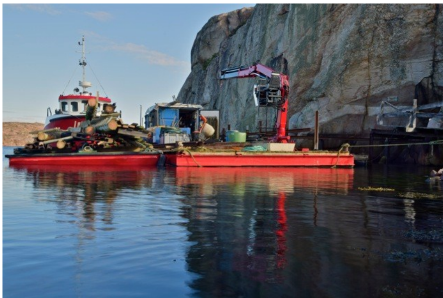
Allfix från Skafjö har påbörjat arbetet med att riva den gamla containerbryggan för att ge plats åt den nya.
