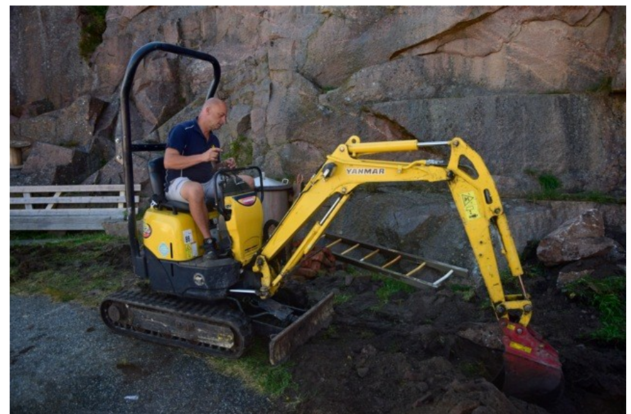
Johan Kylbrink sitter vid spakarna när det grävs avlopp i hamnen på arbetsdagen.
