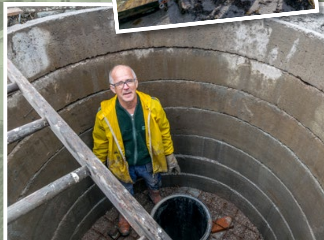
Leif Jonsson har precis avslutat arbetet med att lägga armeringsjärn i botten av pumpreservoaren.
