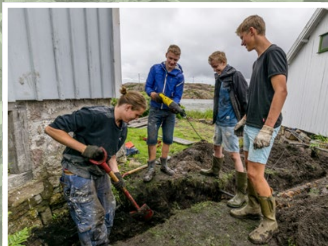
Avloppsarbetet har fortsatt under året. Här ser vi några av våra duktiga ungdomar som gräver nedanför Nybergs hus.
